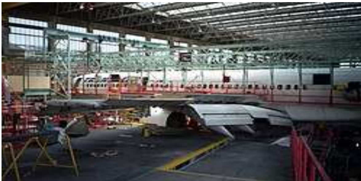
Рис. Техническое обслуживание и ремонт объекта
