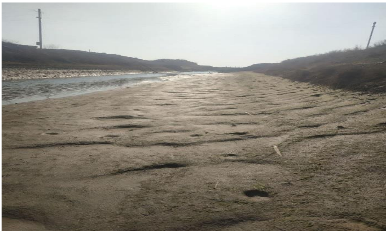
Рис 5. Вид на гряды в промежуточном участке ПК 1140+50÷1143+50
