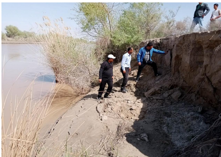
1-Rasm. Amu-Buxoro mashina kanalining PK 950 da o‘ng qirg‘oq yuvilishi holati
