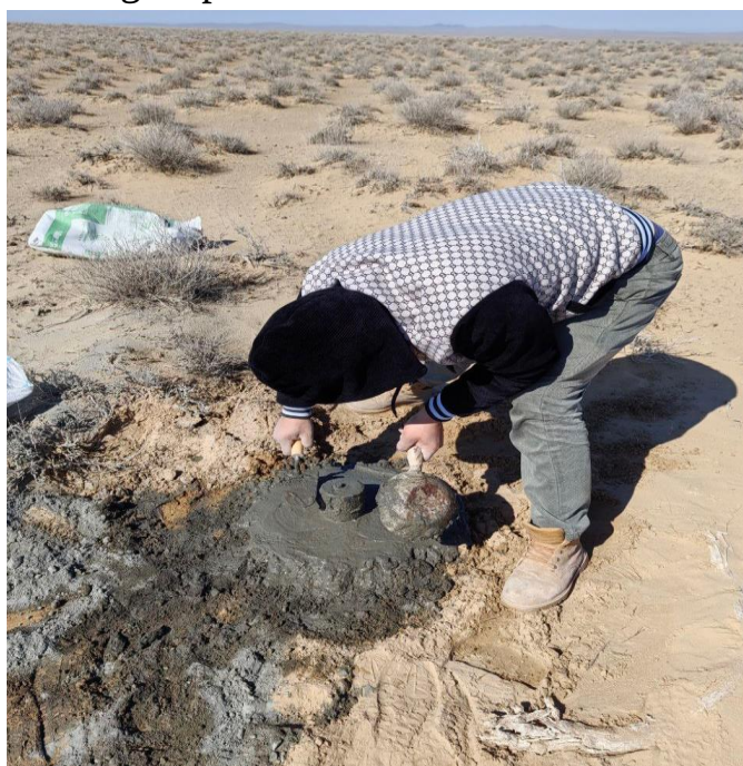
2-rasm. Geodezik asos nuqtalari mahalliy sharoitda mustahkamlash
