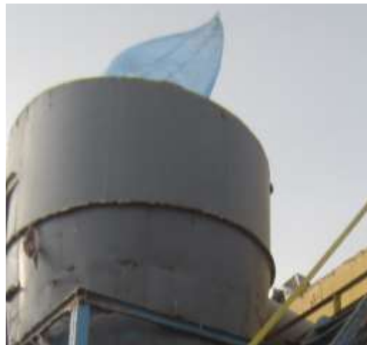
1-расм. Циклоннинг атмосферага чиқиш туйнугига фильтрни ўтнатиш.
