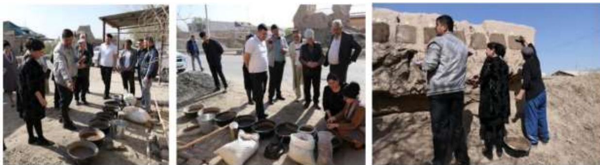
Stabillashtirilgan tuproqlarni tayyorlash va gips namunalarini eski devorga qo'llash
