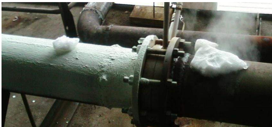
1-rasm. «Izofull»ni quvurlarda qo'llanishi
