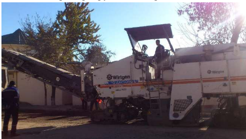
Рис.2 Дорожные фрезы Wirtgen 2000
