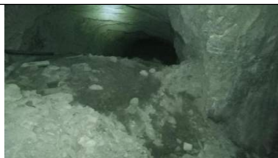
Рис.1.4. Достигнутый контур выработки сечением 7,8 м 2 при действующем паспорте БВР на рудники Каракутан.
