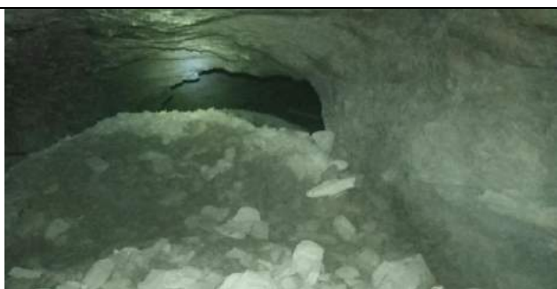
Рис.1.3. Достигнутый контур выработки сечением 7,8 м 2 при промышленных испытаниях по предложенной методике расчета паспорта БВР.
