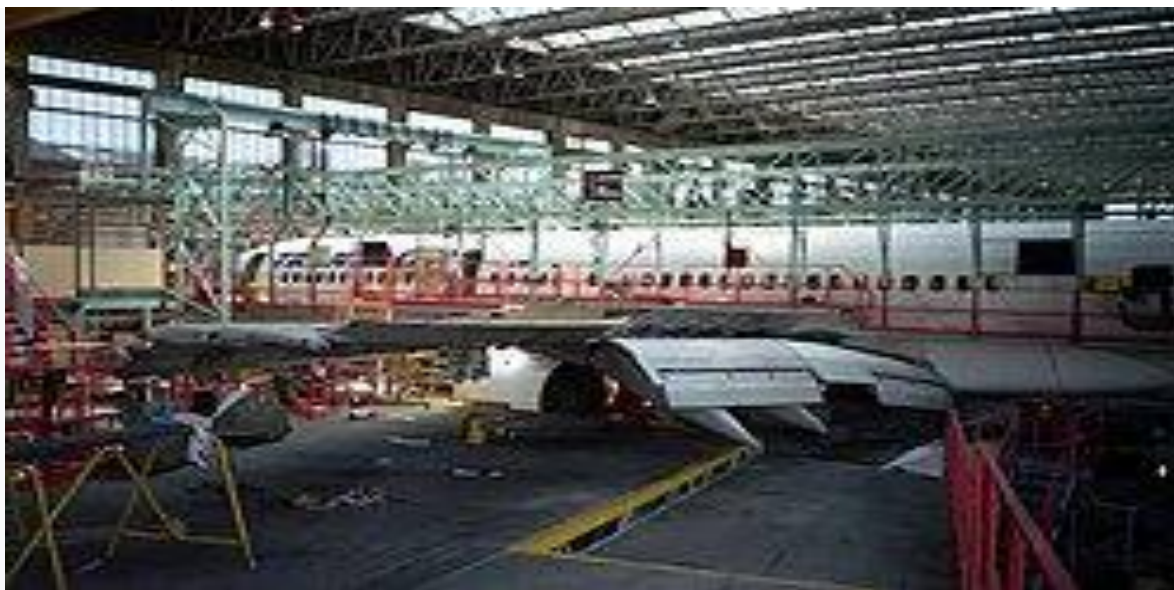
Рис. Техническое обслуживание и ремонт объекта
